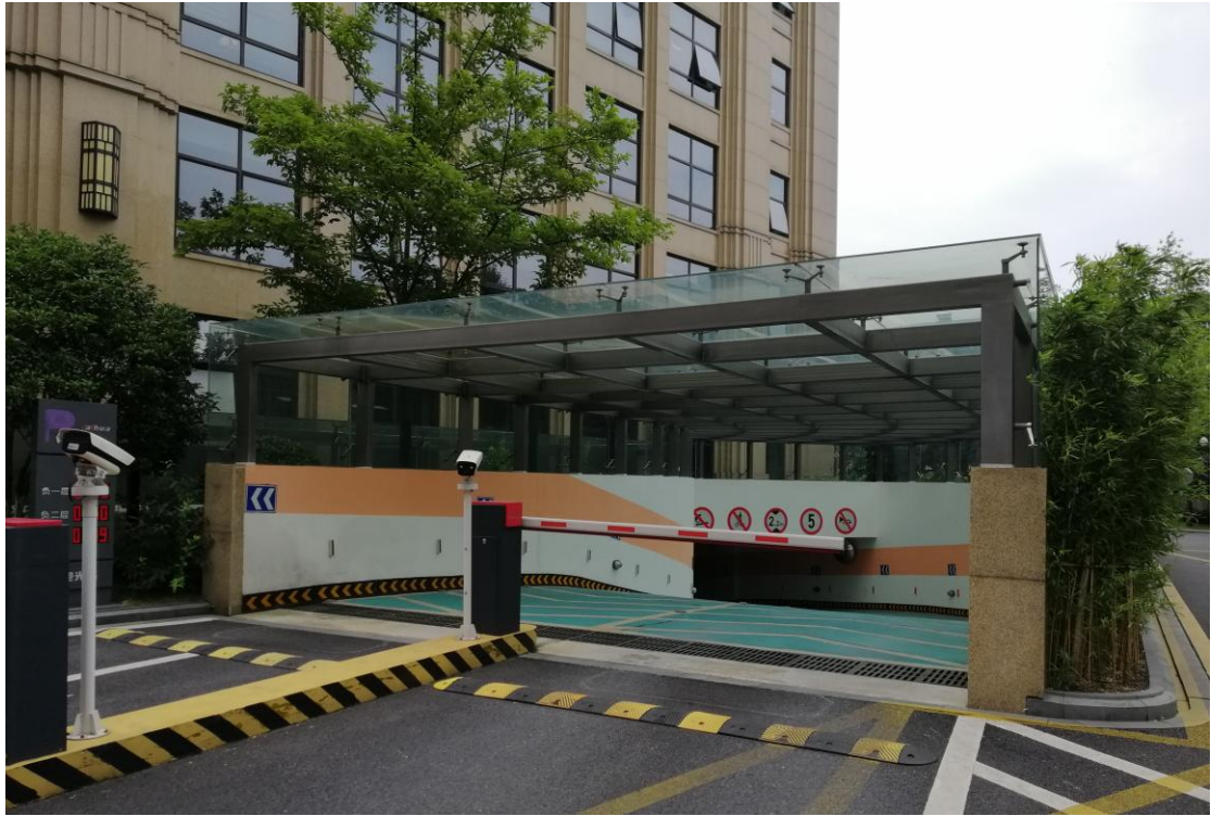
地下车库出入口（低噪声坡道、隔声顶棚、禁鸣限速标志）
