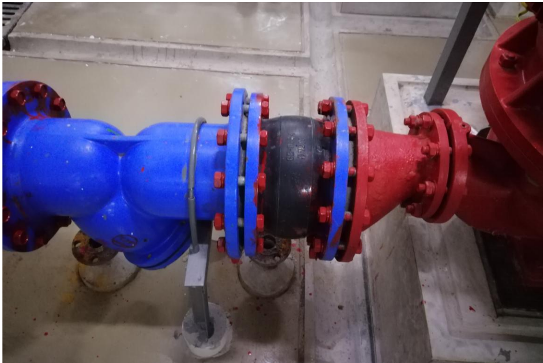
水泵球型挠性橡胶连接
